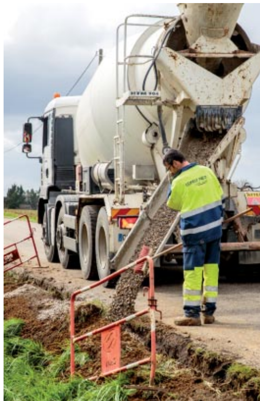
13 mars 2015 : Travaux d'électrification à Saint Martin des Cailles
