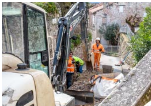
17 mars 2015 : Travaux sur le réseau de gaz dans la rue de Ferracap au bourg de Penne d'Agenais
