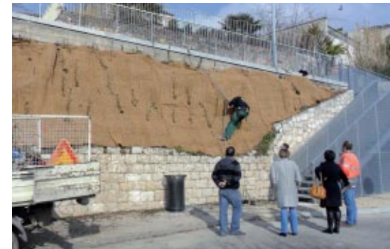
Réhabilitation de l'escalier Venelle du Barry
