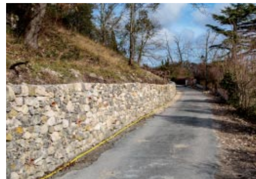
Hiver 2014/2015 : Mur refait à Peyragude par les Services Techniques de la Mairie
