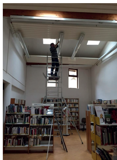
Modernisation de l'éclairage de la bibliothèque
