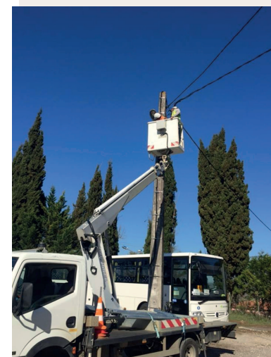
Les équipes du SDEE47 procède à la modernisation de l'éclairage.
